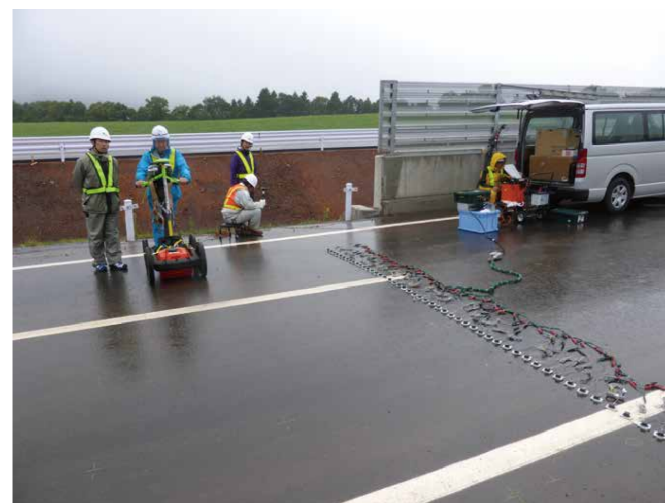
変状箇所での詳細物理探査風景
