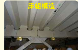
ひずみ計を設置
