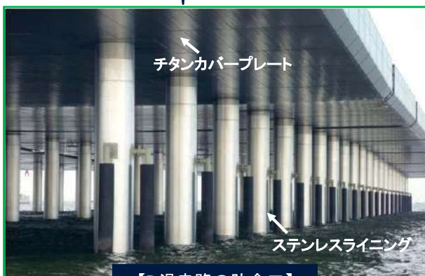
【D滑走路の防食工】
