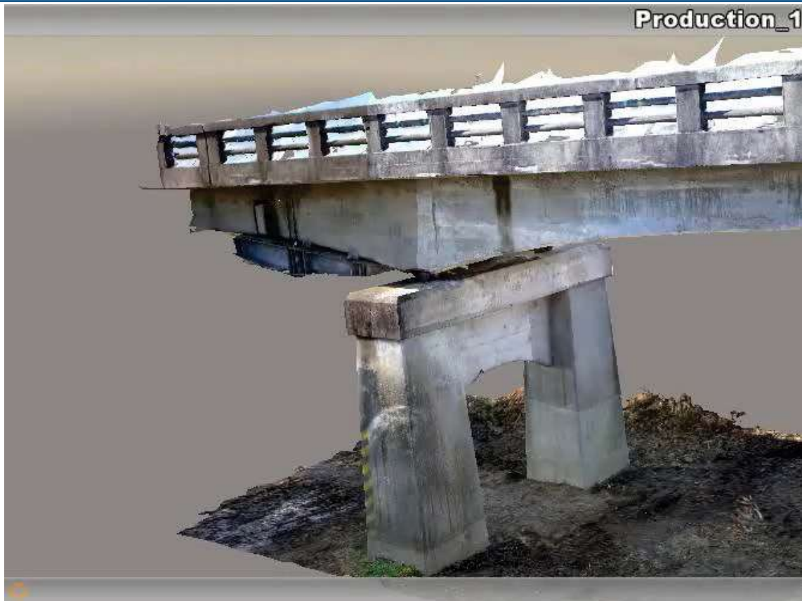
ルーチェサーチ作成（幸久橋現場検証2015） 27
