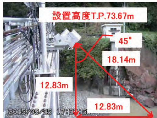
写真-2 電波式流速計の設置例
