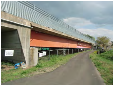
東北自動車道 大森川橋
