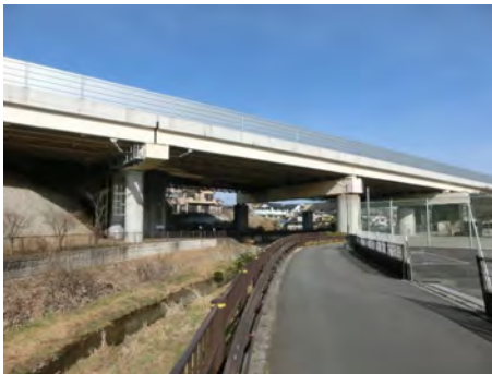
中央自動車道 城山川第二橋
