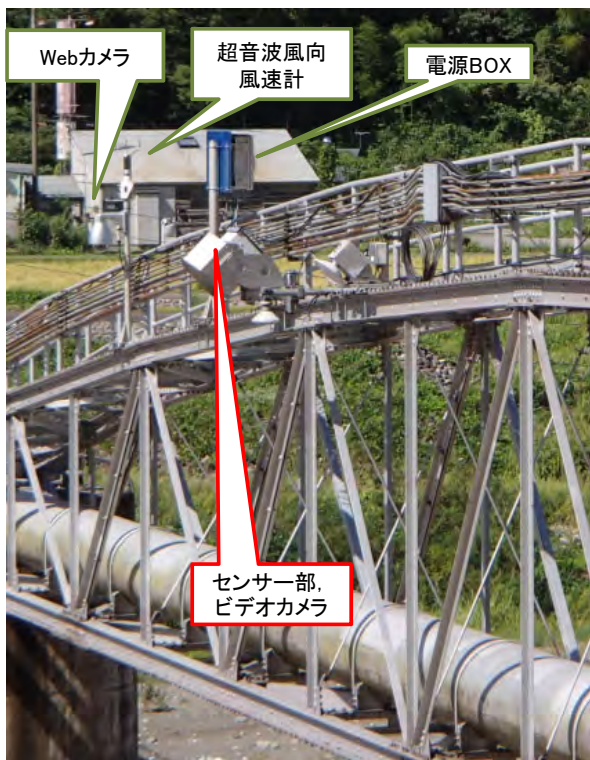
右岸(局舎近く)から撮影
