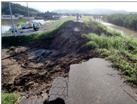
写真-1 小田川の浸透滑りの痕跡
