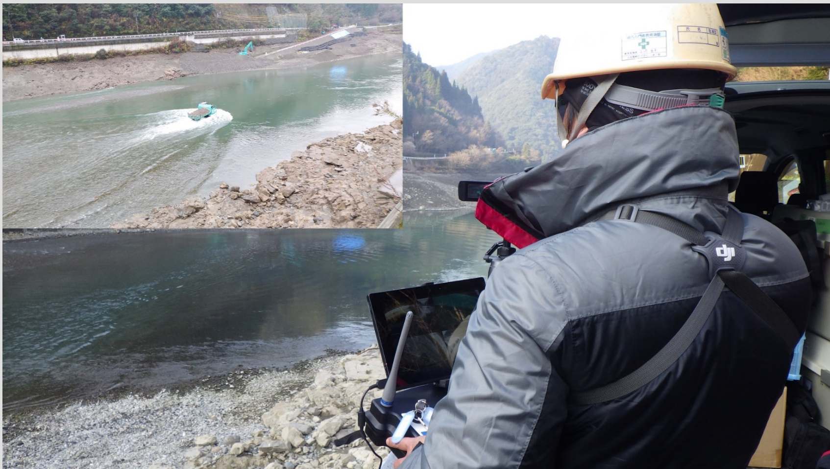
遠隔操作による半水中作業システムの開発 UC-TEC (SIP)
