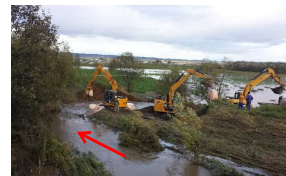
緊急締切工事の事例
