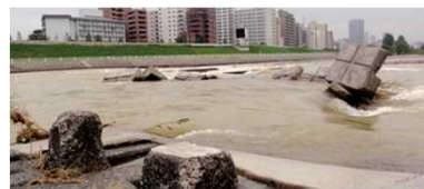
豊平川床止工近傍の写真 (平成23年9月出水後 北海道開発局提供)
