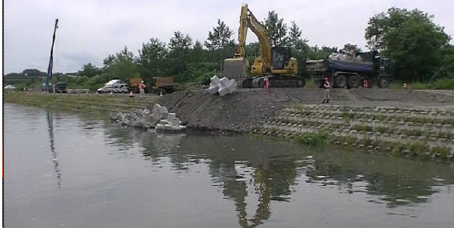
締切資材の投入実験
