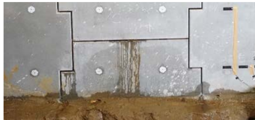
Case1での目地部からの排水状況(最下段)
