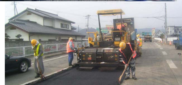
維持修繕工事
