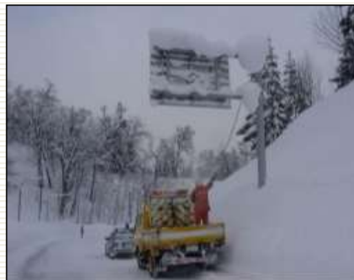
▲ F型標識背面の除雪作業
