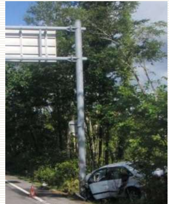
▲F型標識に衝突した事故事例 (支柱損傷は塗装の「はがれ」のみ)
