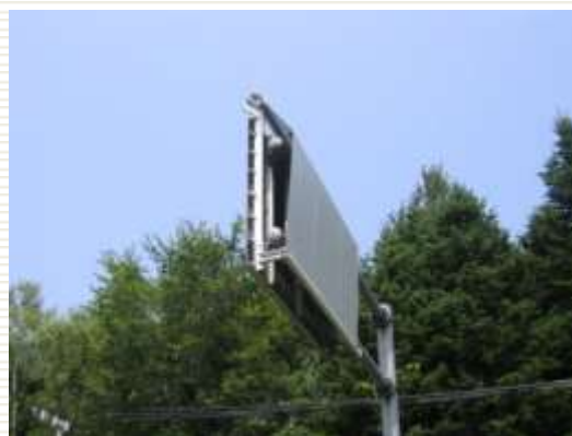
▲ 着雪防止シートの設置事例
