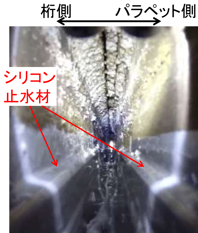
シリコン止水材の塗布後
