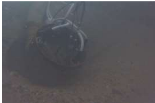
吸引部の土砂吸引の状況(水中)
