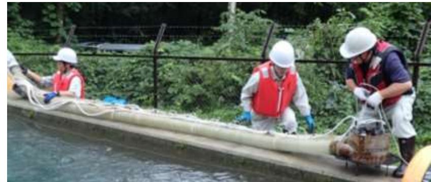
管径100mm潜行吸引式排砂管
