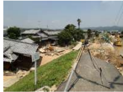
2018年岡山県倉敷市真備町の被害
