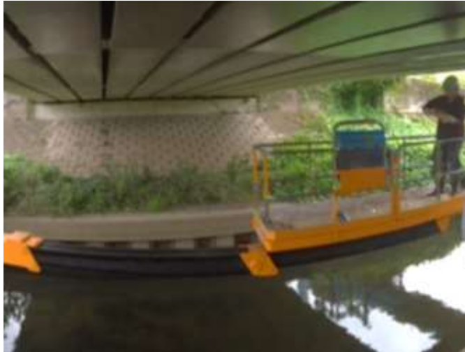
施工状況(2017年9月)
