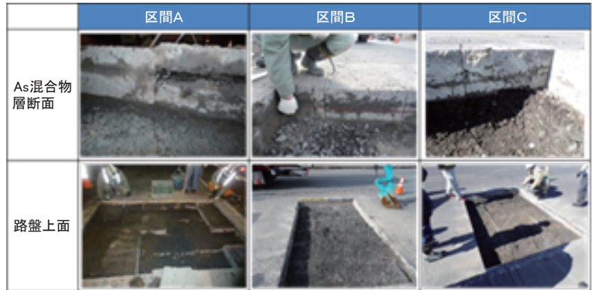
図-6 国道の早期劣化区間の開削調査
