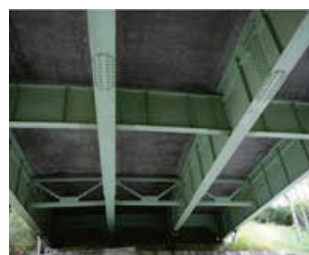
床版下面写真
