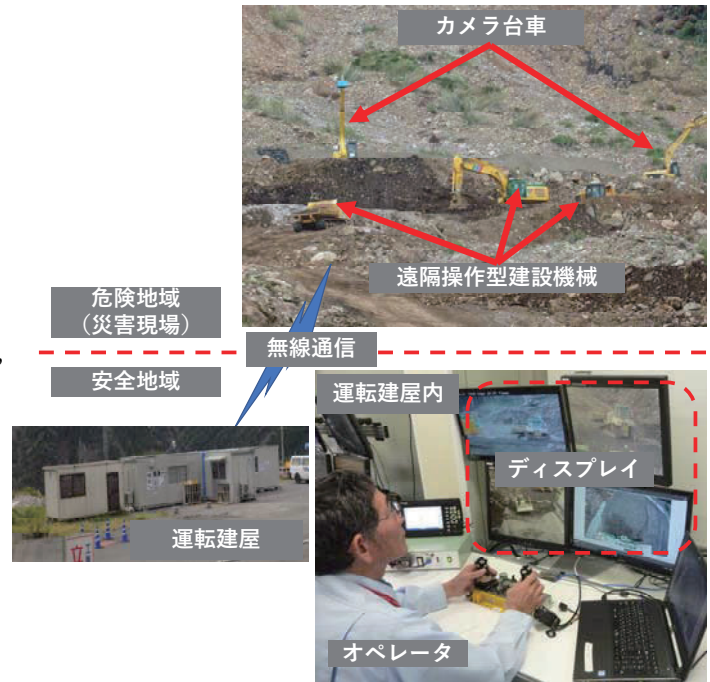
図 4 無人化施工概要 (カメラ画像方式)
