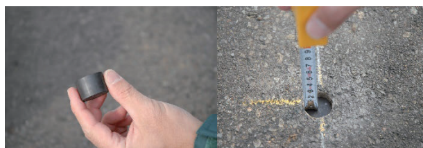
写真-3 磁気マーカ埋設状況
