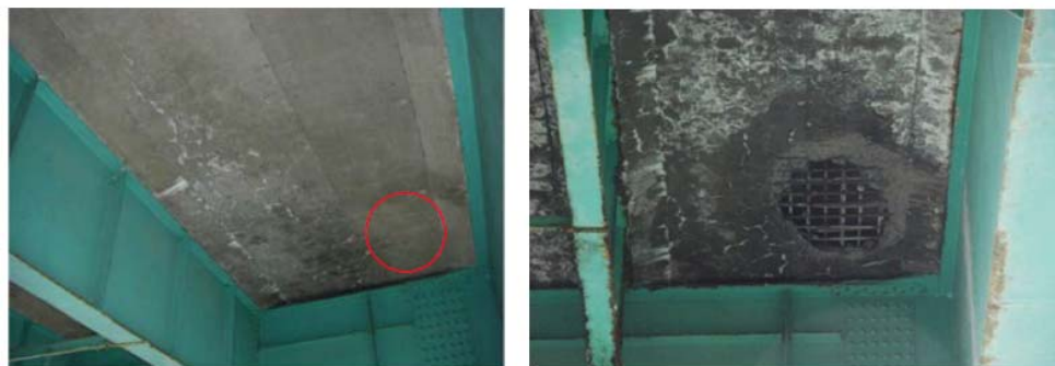
土砂化(砂利化)による損傷
