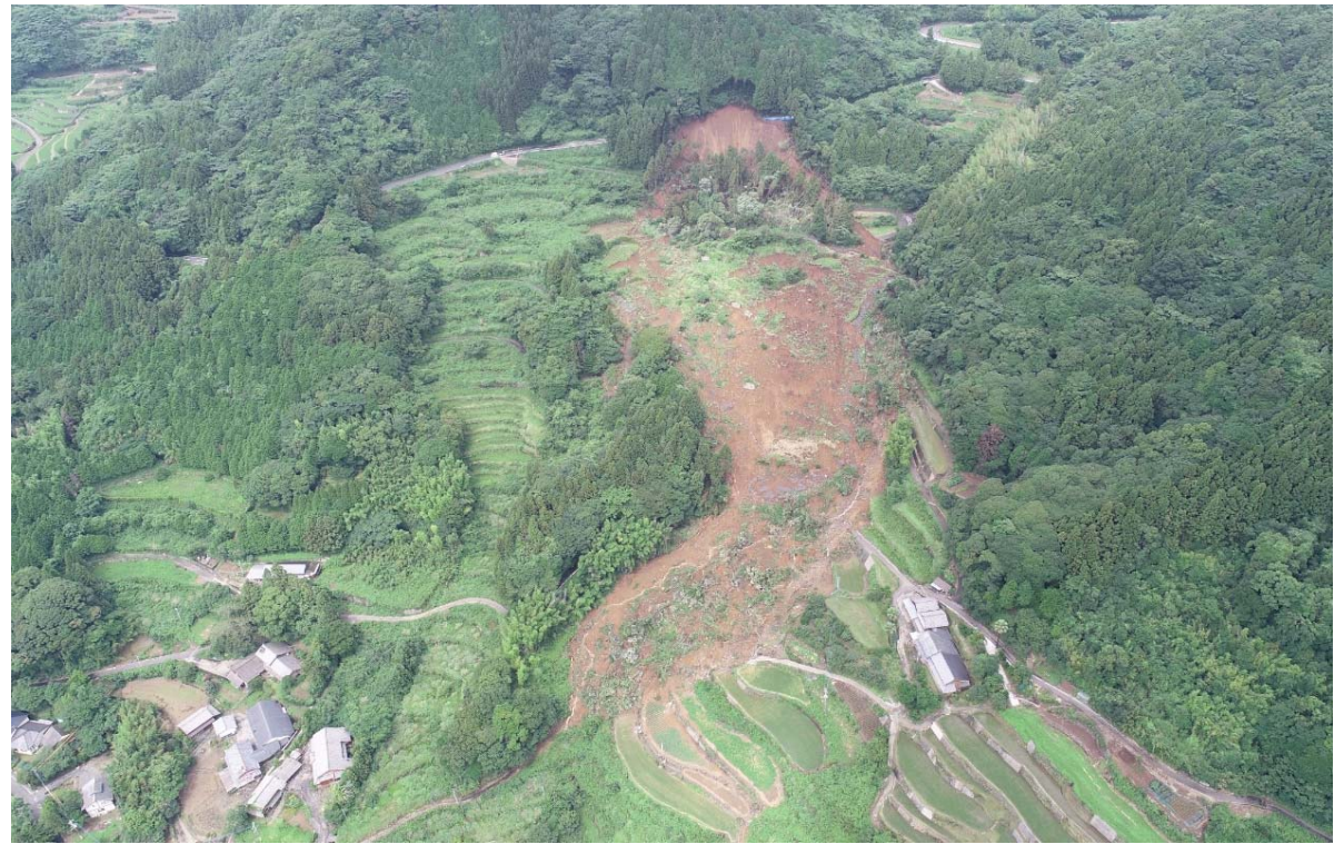
地すべり全景
