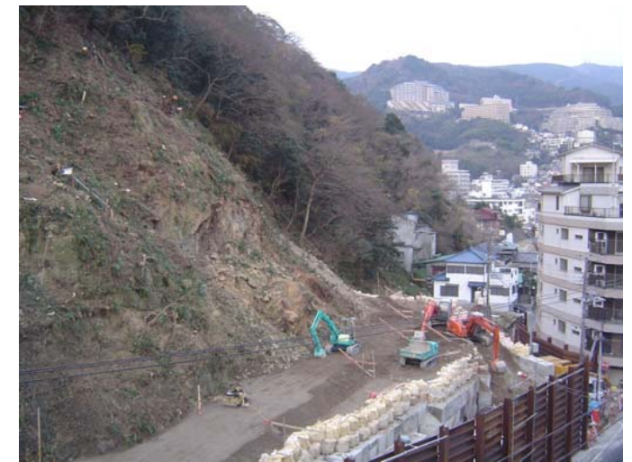
応急対策工事
