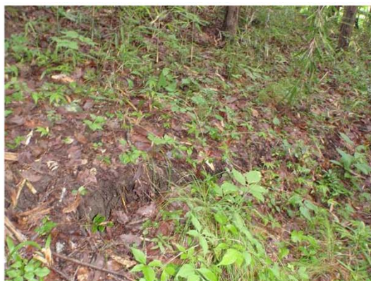
①段差を伴う小規模な開口亀裂
