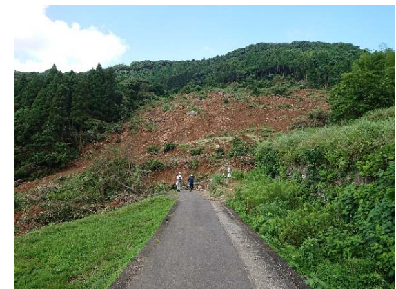
末端の変状部
