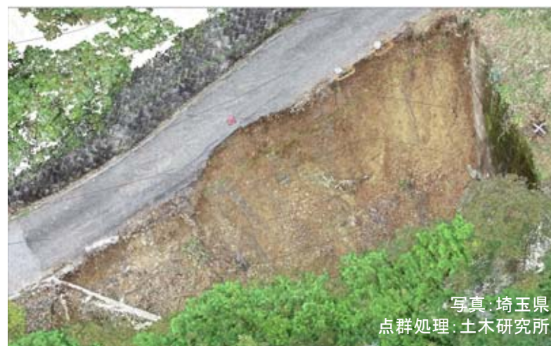
護岸被災箇所周辺CIMモデル
