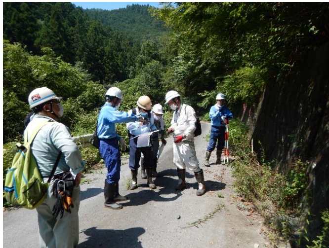
道路周辺の変状の確認
