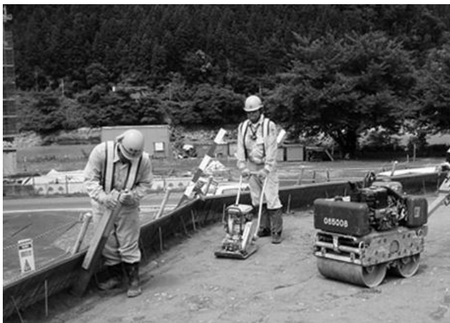
壁面背面の施工
