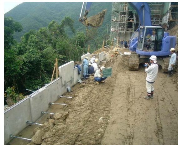
狭隘部の施工
