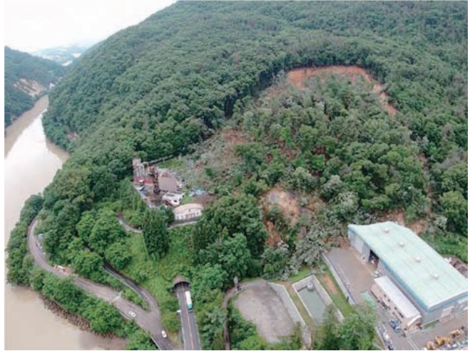
写真1 小松原地区で発生した地すべり
