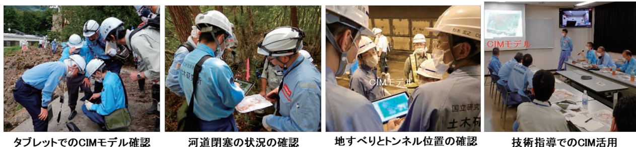
図 3 現地調査状況 (7月7日)
