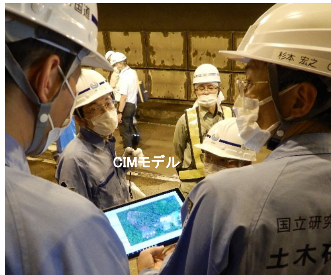
地すべりとトンネル位置の確認
