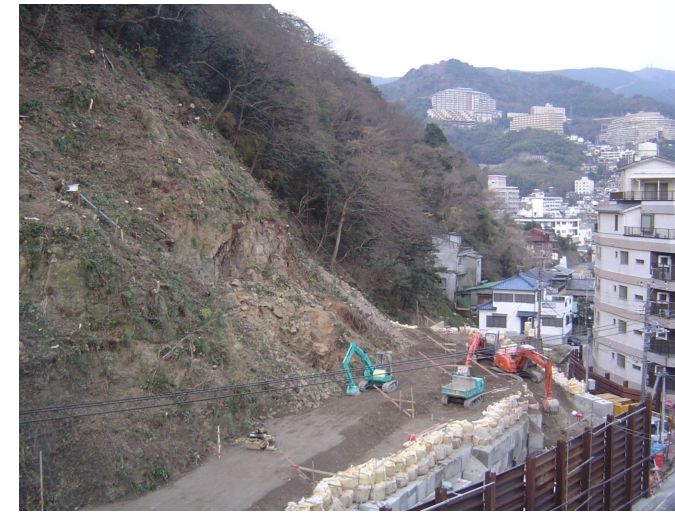
応急対策工事
