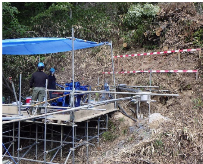
地下水排除工(長野県)
