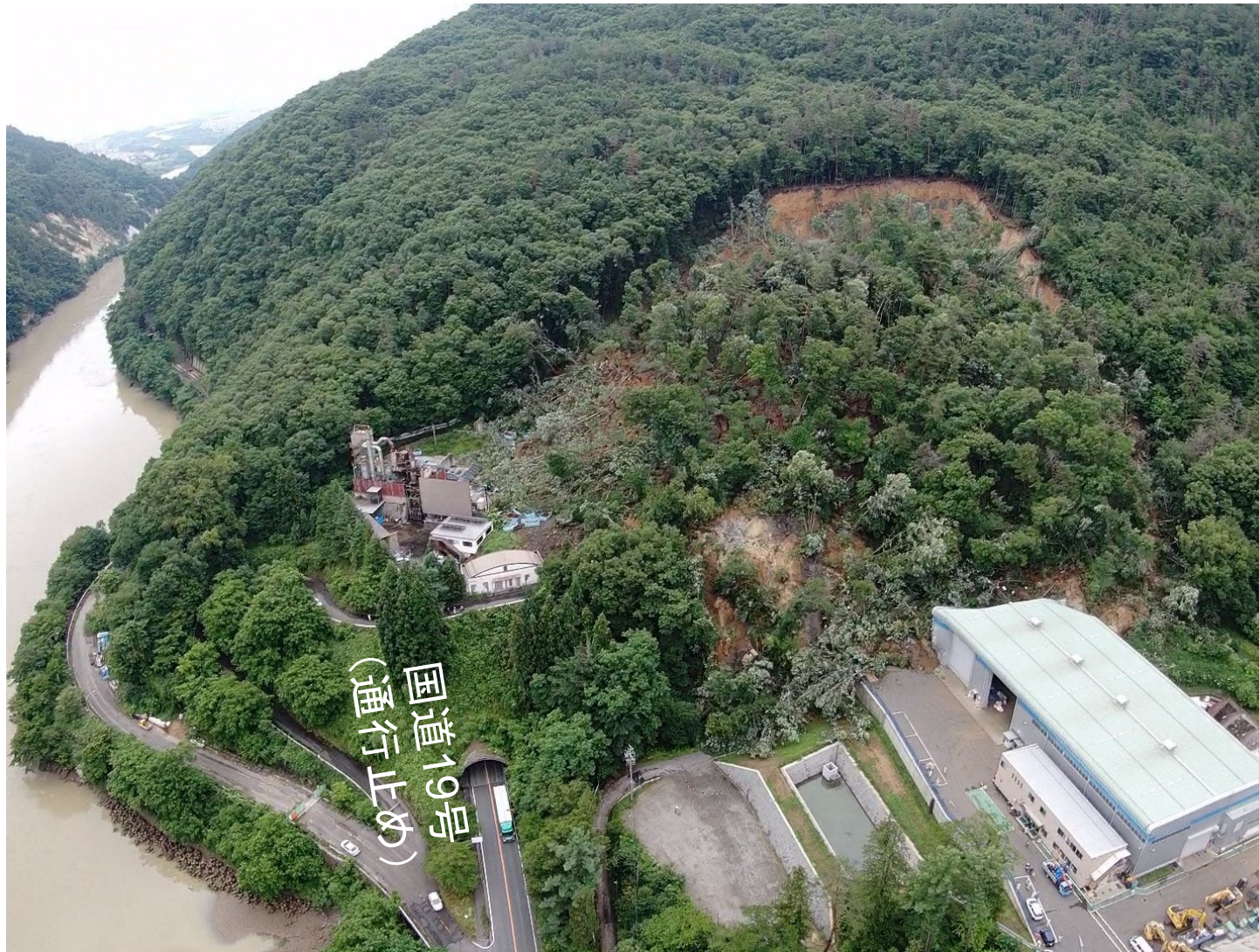
国道19号長野市篠ノ井小松原地区
