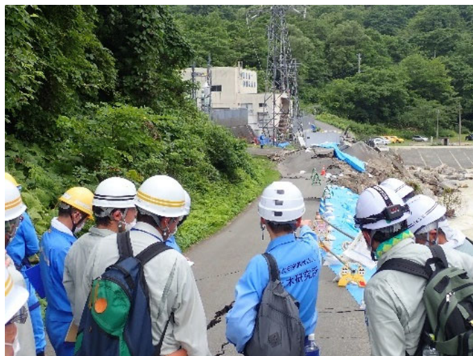
緊急的な現地調査
