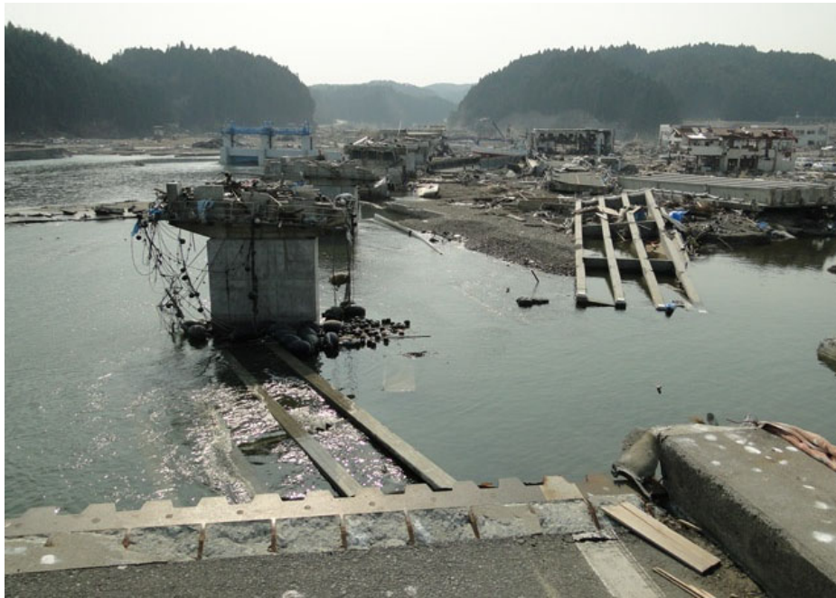
歌津大橋(2011年東北地方太平洋沖地震で発生した津波の影響による上部構造の流出)
