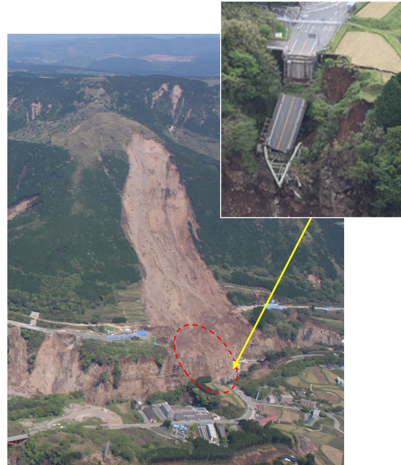
阿蘇大橋(2016年熊本地震で発生した斜面崩壊の影響による崩壊)
