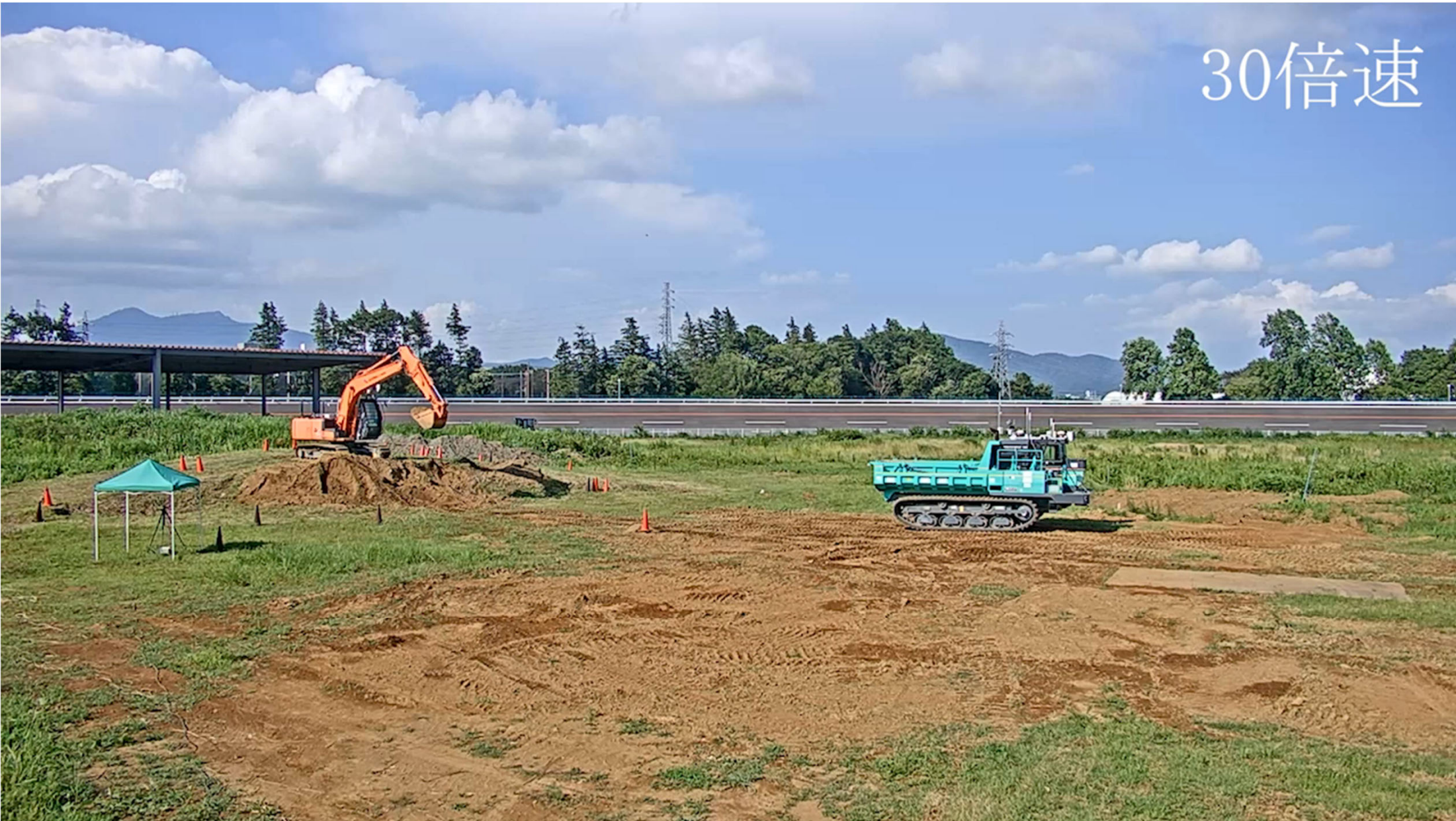
OPERAを活用した自律施工デモンストレーション 2021.11
