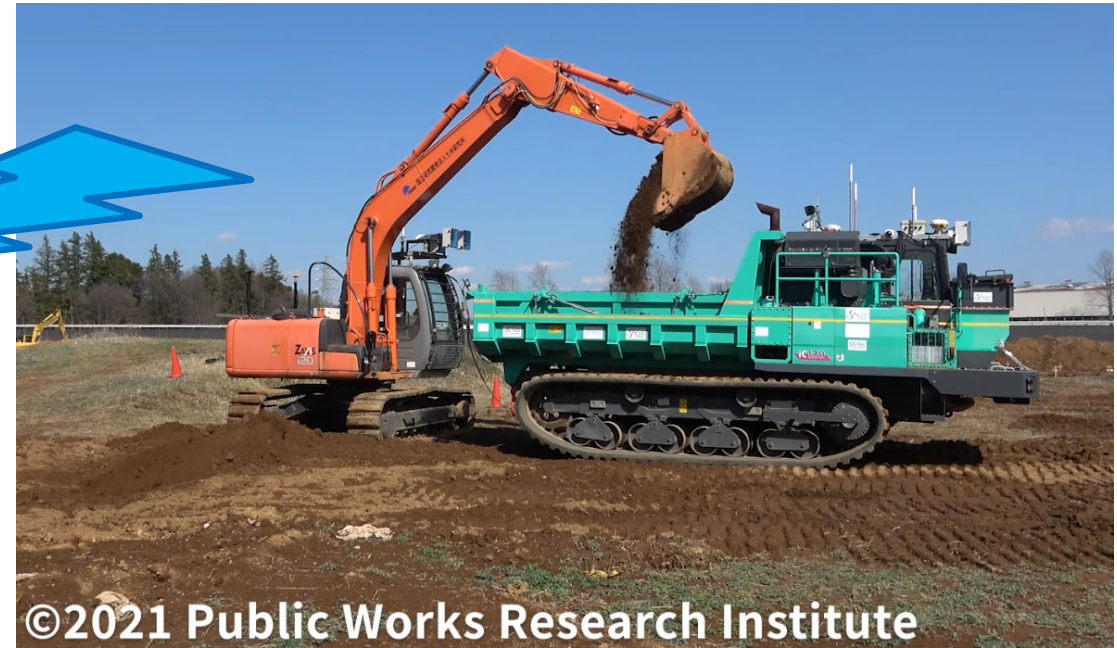
施工現場（ロボット化された建設機械群）
