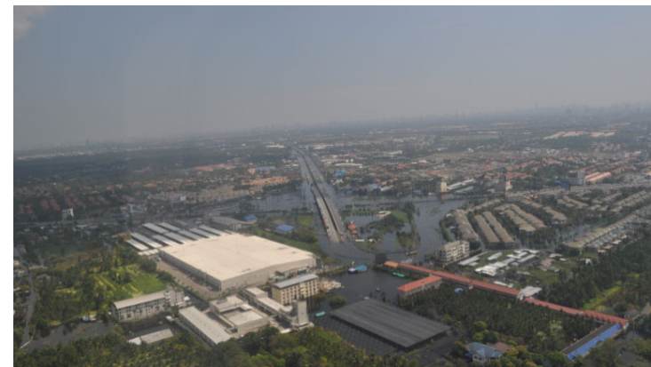
工業団地の浸水状況 (航空写真 by ICHARM スタッフ)
