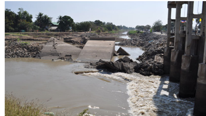
チャオプラヤ川洪水災害(破堤)の状況 (JICAのHPから引用 https://www.jica.go.jp/oda/project/1103372/index.html )
