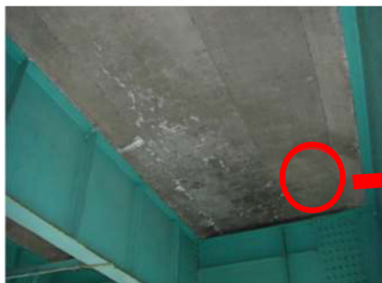
損傷の兆候無し(5年前)
