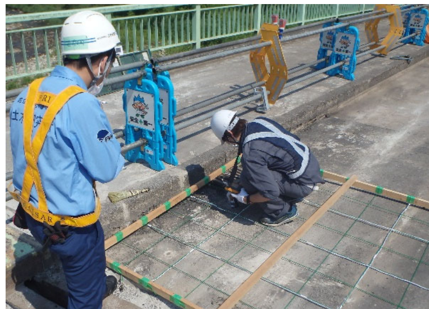
床版上面水分量計測
