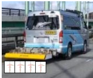
電磁波レーダによる計測
