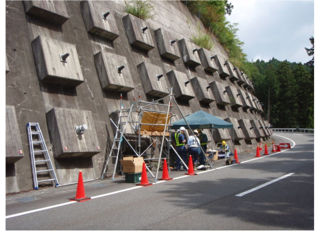
施工後に設置
