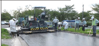
樹脂防水材料施工状況
