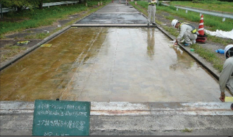
樹脂防水材料施工状況
