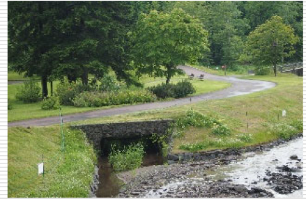
⑤小橋梁の架設位置
