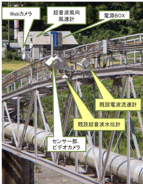
右岸(局舎近く)から撮影
