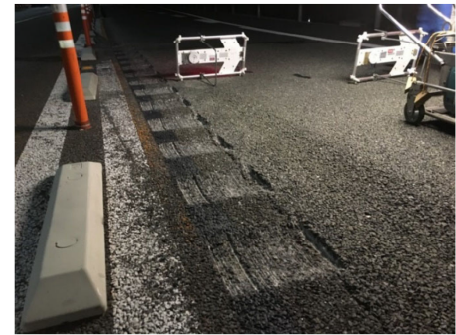
大型車対応ランブルストリップス施工状況
