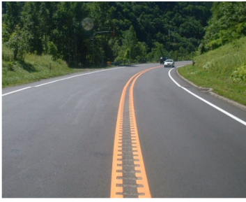
一般国道230号(札幌市)
