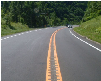
一般国道230号(札幌市)
