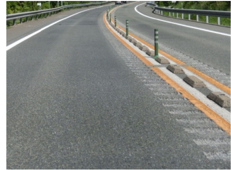
京都縦貫道(園部IC~丹波IC)に設置された大型車対応ランブルストリップス
