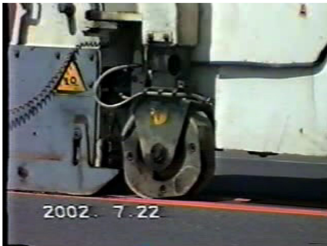
専用施工機械による施工状況
