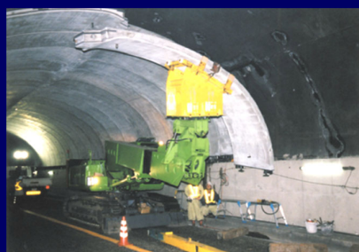
①施工写真
