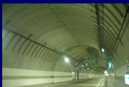
②完成写真
