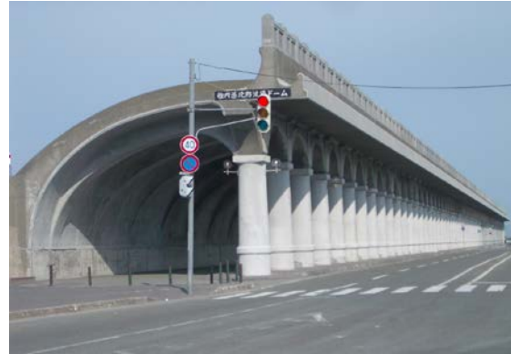
写真-1 稚内港北防波堤ドーム
