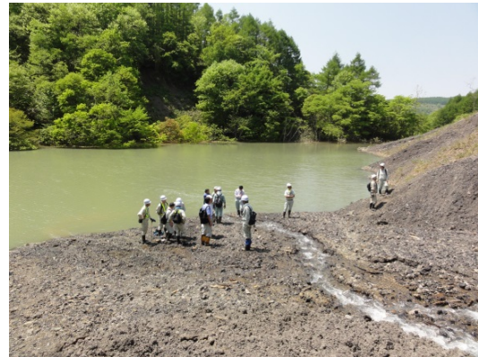
写真-2 夕張市のぼた山崩壊で形成された天然ダム
