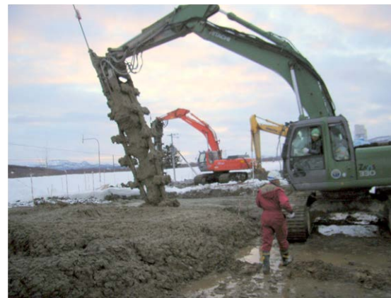
写真-2 新しい地盤改良技術 （トリンチャー式中層混合処理工法）
