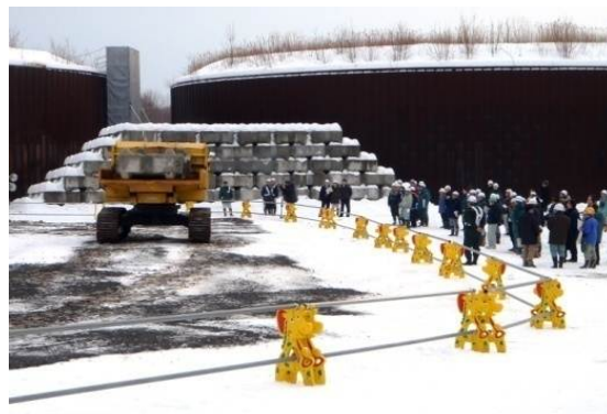
写真-2 無人クローラダンプによる運搬作業
