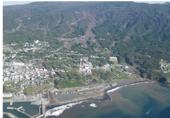
写真-1 東京都大島町の土砂災害
