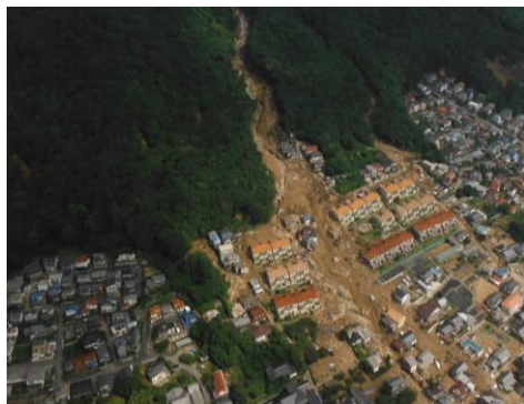
写真-1 広島県広島市安佐南区八木地区で発生した土石流災害
