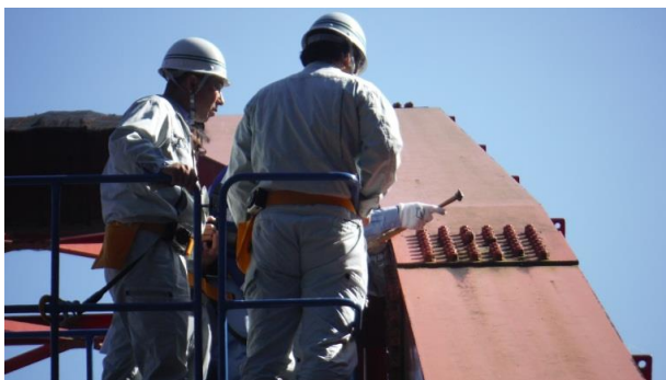
写真-1 ボルトの確認状況
