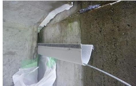
写真-2 ポリプロピレン製排水装置
