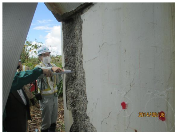
図-2 剥離度の測定
