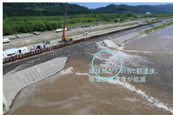
写真-2 ブロックにより破堤拡幅が抑制 （越水開始から約30分後）
