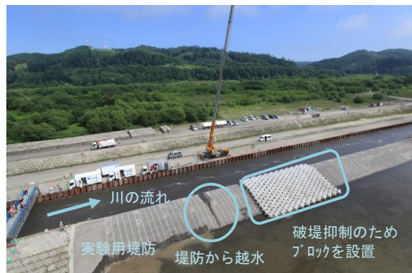
写真-1 水位が上昇し堤防から越水
