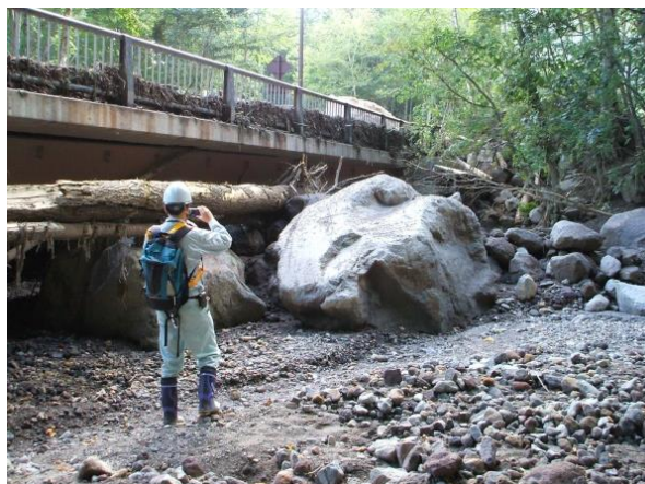
写真-2 国道453号の土石流災害
