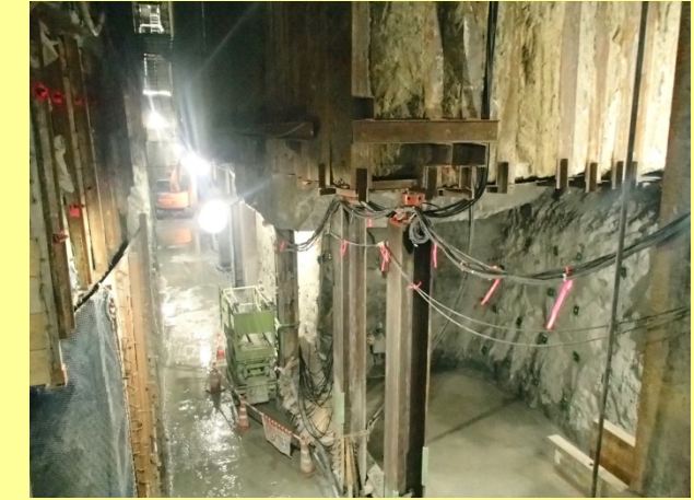
■アンダーピニング施工状況
