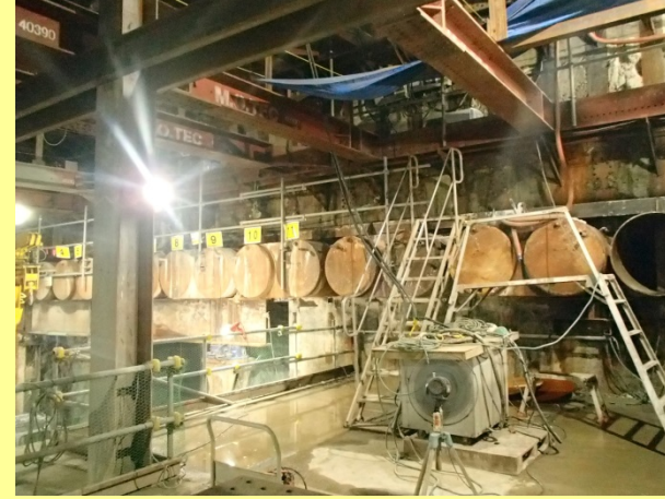
■パイプルーフ施工状況
