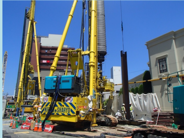
■土留工打設状況
