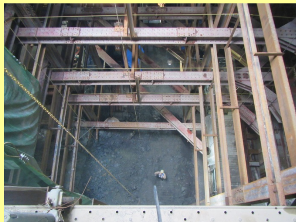
■掘削状況（GL-約20mまで）
