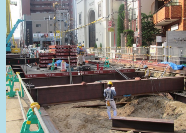
■路面覆工設置状況
