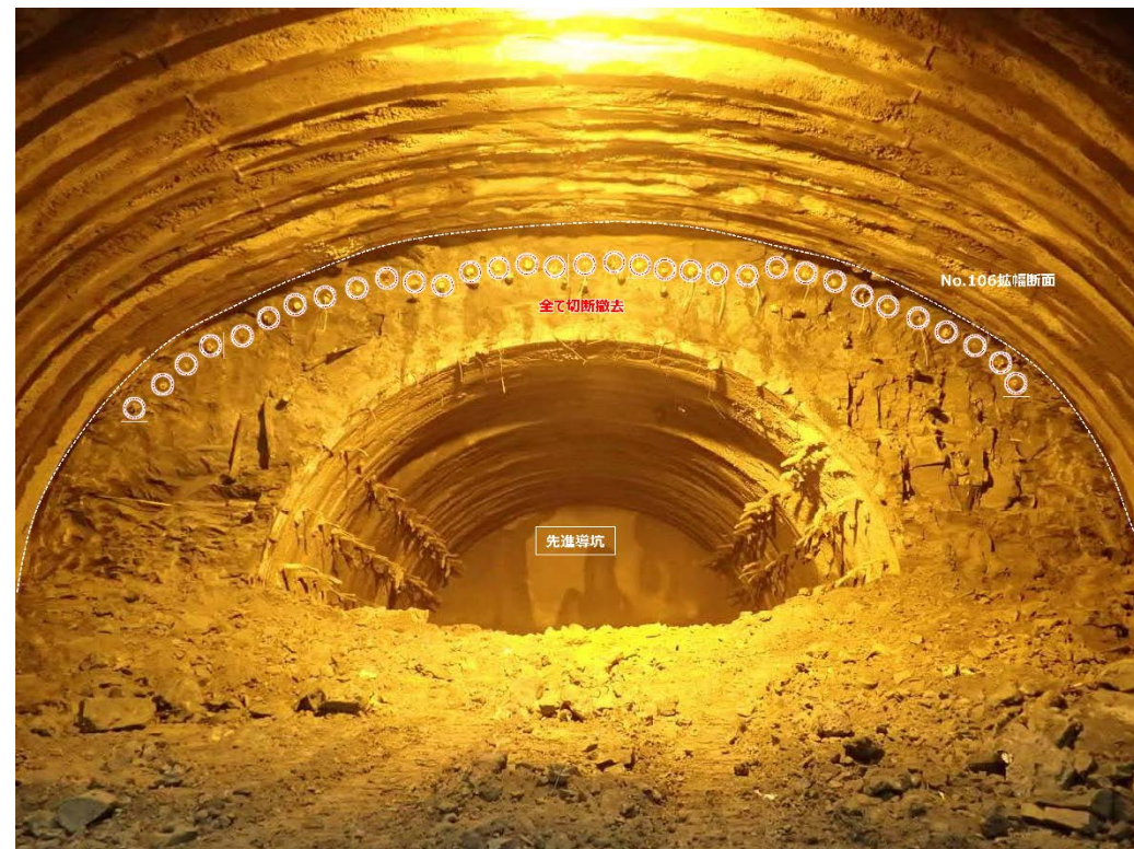
施工者提出資料より
