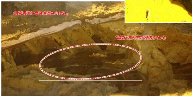
施工者提出資料より
