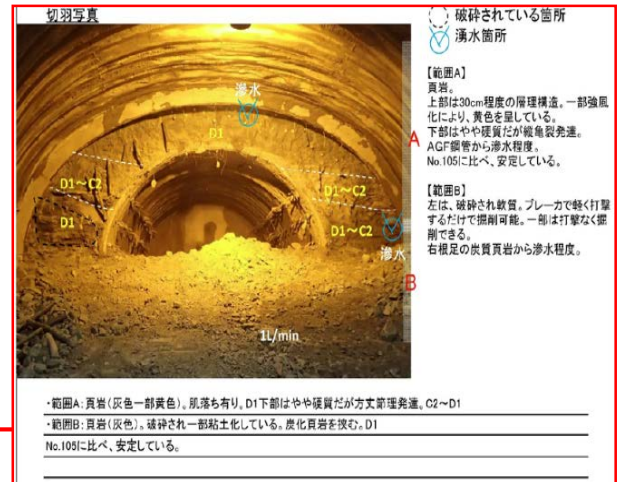
No104 切羽状況写真
