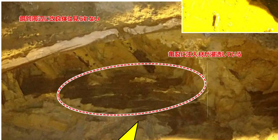
■ 注入状況（3連トンネル I 型中央坑 No.229 断面部）
