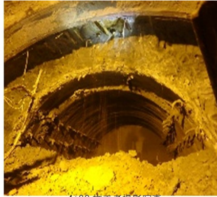
4:30 施工者撮影写真
