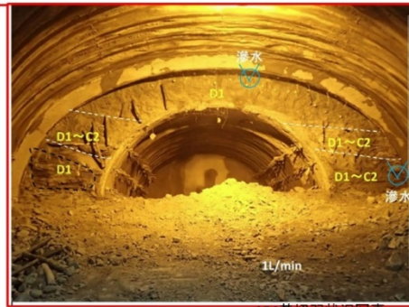
支保工応力が管理基準値 (I) を超える時刻付近の状況 資料提供：施工者 (委員会加工) (第3回検討委員会資料 - 2 より)
