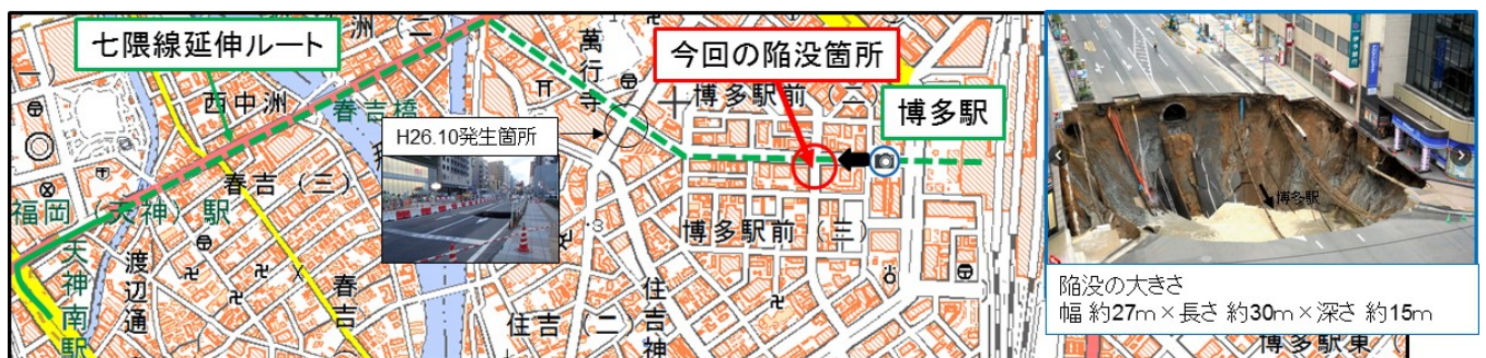
位置図と陥没後の写真
