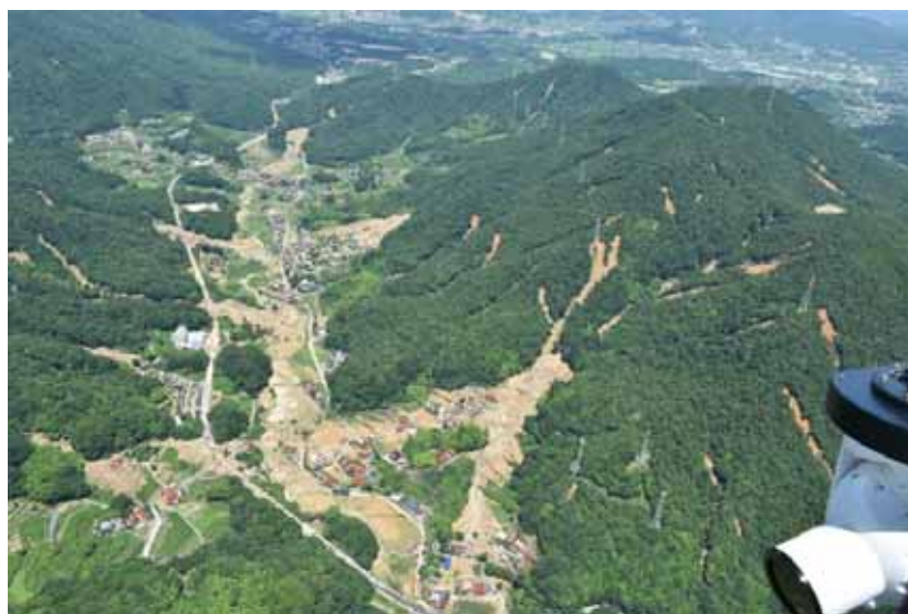
写真-1 呉市安浦町の土石流の発生状況，この地域では多くの箇所で土石流等の発生
