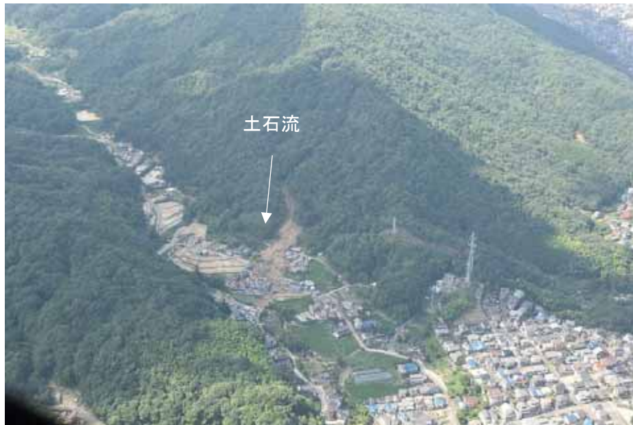
写真-2 安佐北区口田南5丁目の土石流の発生状況，下流で土砂洪水氾濫が発生
