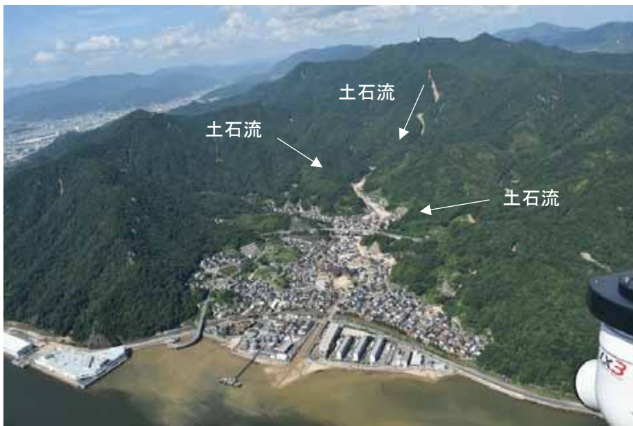
写真-3 坂町小屋浦の土石流の発生状況，集落の三方向から土石流が発生
