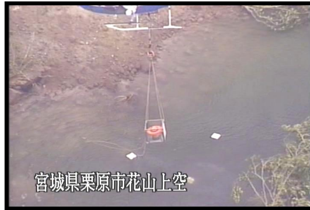
吊り下げ途中の様子
