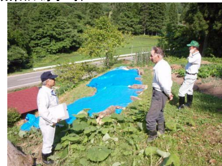
応急対策の状況 (岩手県旧衣川町)
