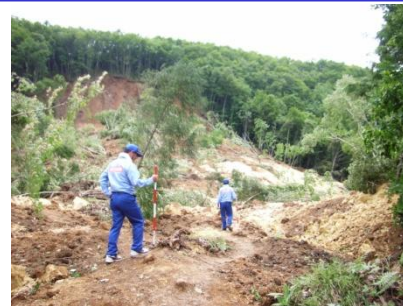
点検で危険度Aと判定された箇所 (宮城県旧栗駒町)
