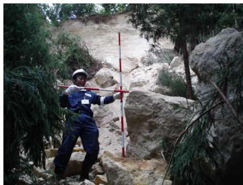
宮城県一迫町での点検状況
