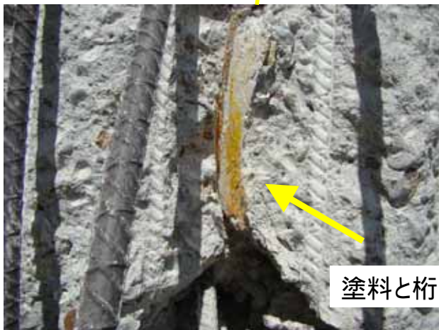
A2橋台パラペットには主げたの衝突痕がみられる
